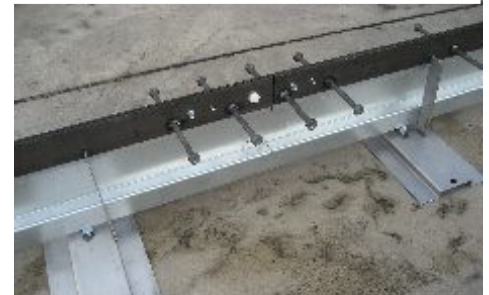
Profilverbindung mit einer Kunststoffschraube
