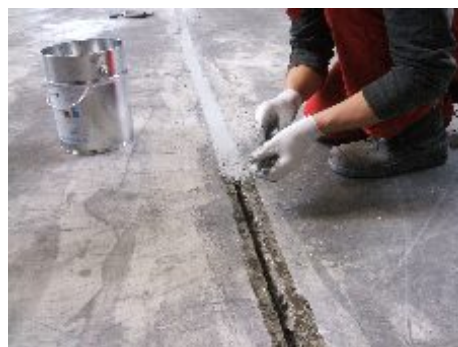
Kantenausbruch nach dem Öffnen der Fuge durch Hubwagenverkehr
