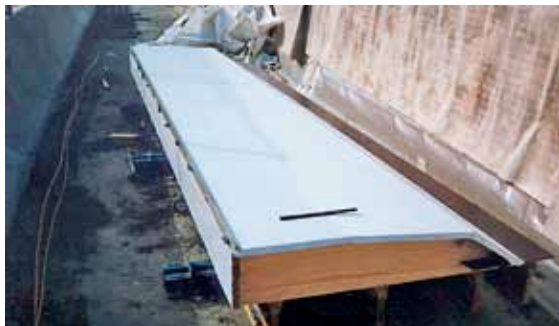
Ein Schalungselement eingekleidet mit Formtex®. Bereit zum Betonieren.
