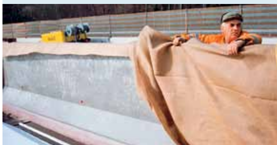
Das fertiggestellte Element – bereit, ohne jegliche Nachbehandlung des Betons.
